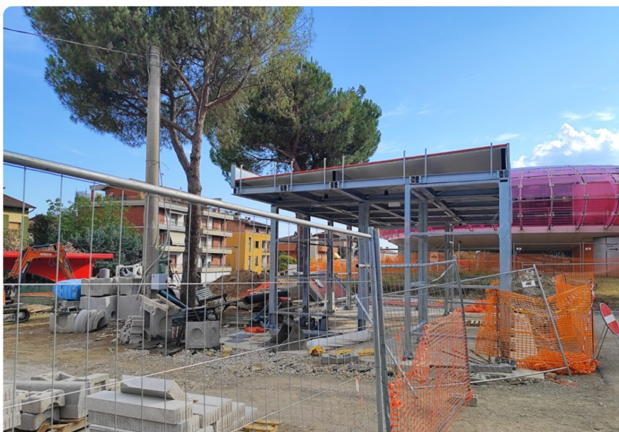
Cantiere presso l'area della biblioteca
